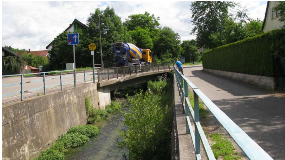
Abbildung 1: Kreuzbachbrücke in Iptingen, Regierungsbezirk Karlsruhe
