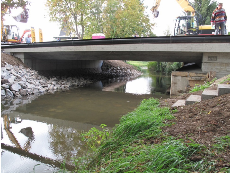
Abbildung 2: Kraichbachbrücke in Ubstadt, Regierungsbezirk Karlsruhe
