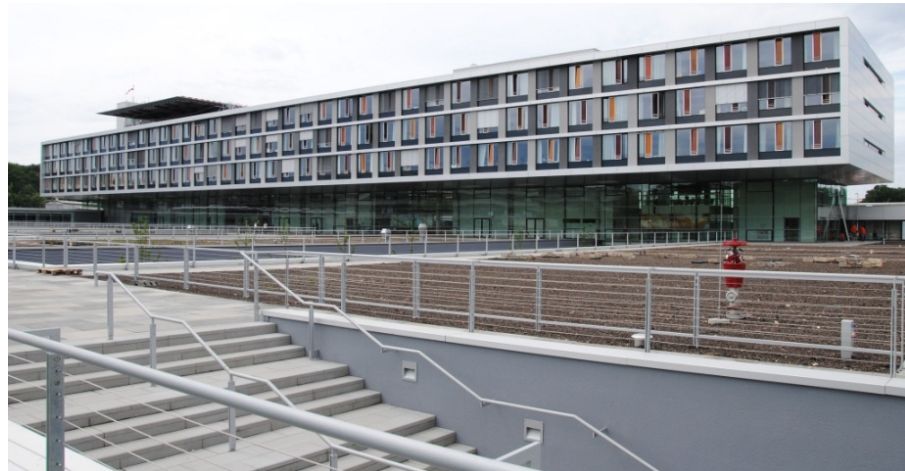
Abbildung 1: Ansicht des Neubaus von Osten
