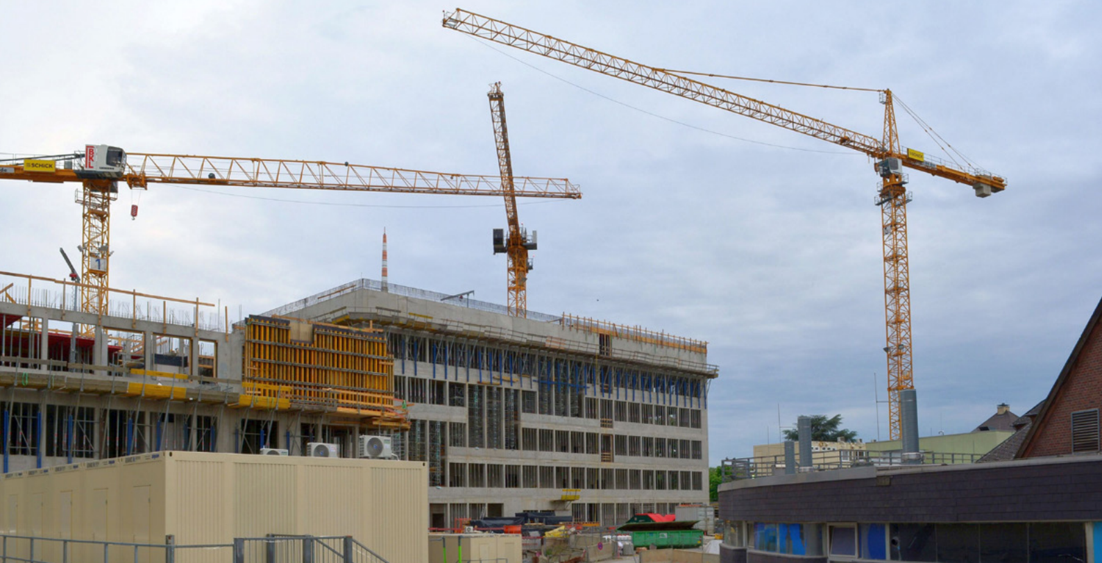
Abbildung 24-5: Baustelle MaReCum am Universitätsklinikum Mannheim
