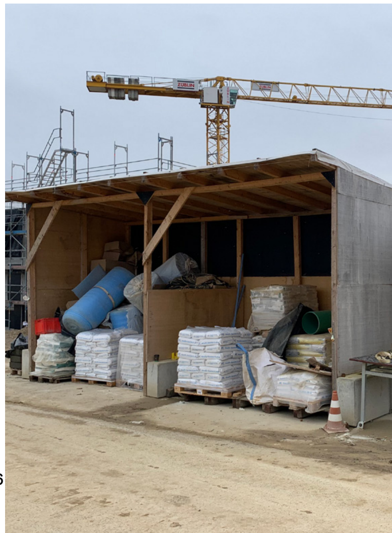
Abbildung 24-4: Unternehmensspezifische Baustelleneinrichtung (Justizvollzugsanstalt Rottweil)
