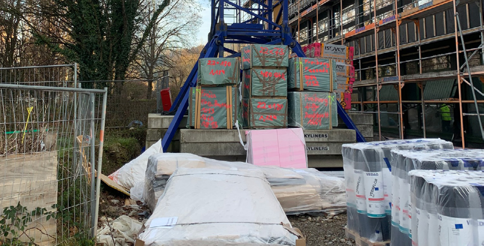
Abbildung 24-3: Sehr beengte, innerstädtische Baustelle (Pädagogische Hochschule Freiburg)
