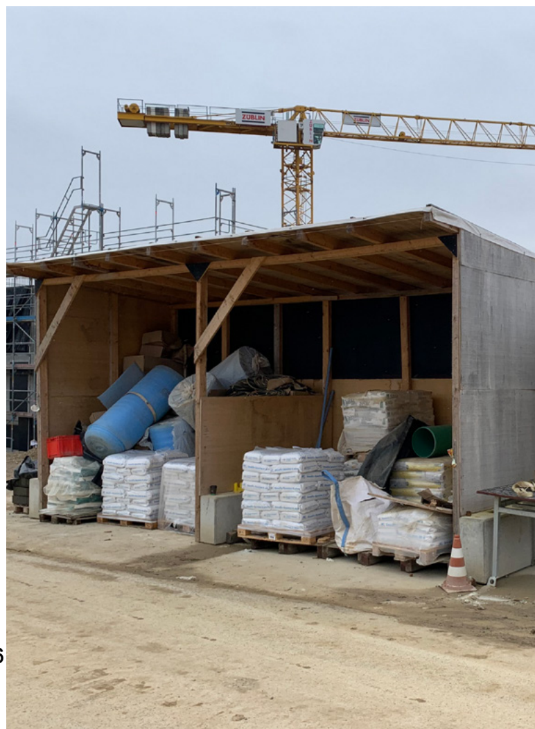
Abbildung 24-4: Unternehmensspezifische Baustelleneinrichtung (Justizvollzugsanstalt Rottweil)
