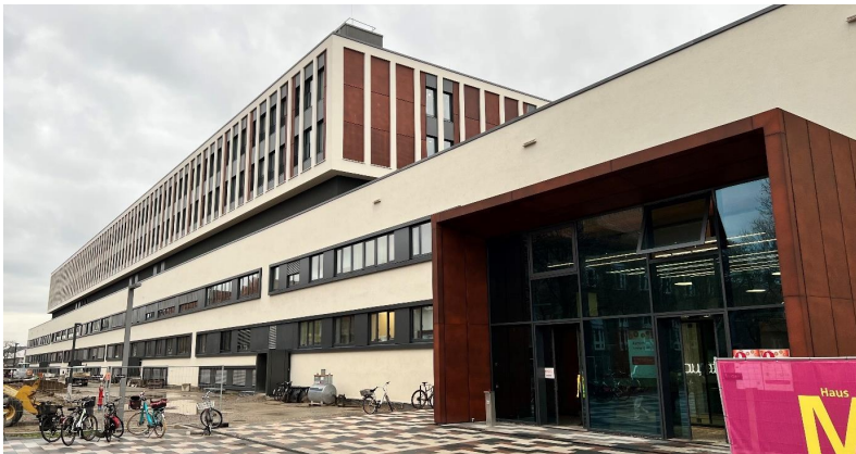
Abbildung 16-1: Haus M mit zentralem Haupteingang
