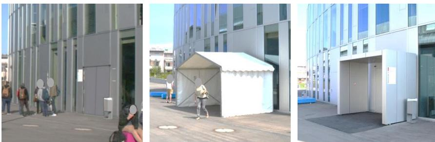
Um größeres und schweres Material zwischen Kellergeschoss und Erdgeschoss zu transportieren, wurde ein außen liegender Lastenaufzug gebaut. Dieser befindet sich auf der Rückseite des Gebäudes inmitten einer Wiese. Der Lastenaufzug ist mit keiner befestigten Verkehrsfläche erschlossen und kann mit einem Transportfahrzeug nicht erreicht werden. Zur Herstellung einer sicheren und befahrbaren Verkehrsfläche werden Mehrkosten entstehen.
