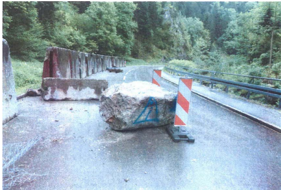
Abbildung 2: Felsschlag an der L 175 Schramberg-Tennenbronn, Regierungsbezirk Freiburg
