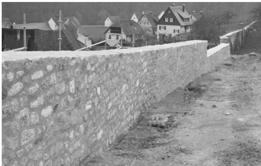
Abbildung 3: Nördliche Ringmauer nach der Sanierung
