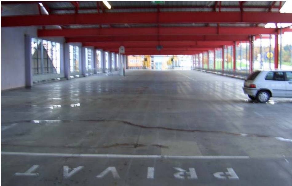
Auslastung der Park-and-ride-Stellplätze im Parkhaus
