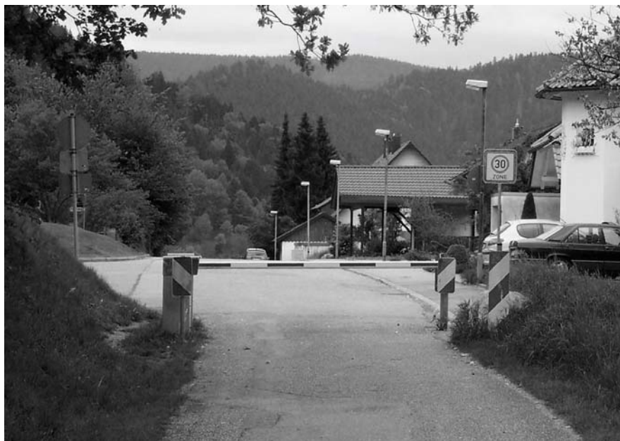
Schranke an einer angeblichen Gemeindeverbindungsstraße
