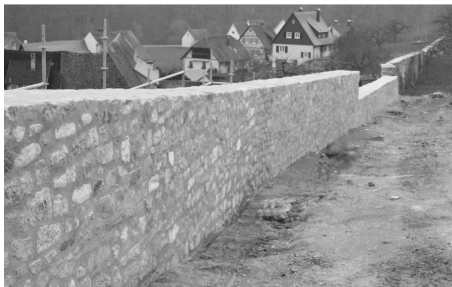
Abbildung 3: Nördliche Ringmauer nach der Sanierung
