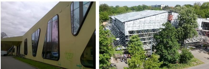
Abbildung 17-1: Mängeluntersuchung (2017, links), Schutzdach (2023, rechts)
